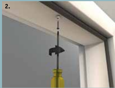
Einfache Montage: 1.) vetroMatic wird auf die Tür aufgeschoben 2.) An der Zarge ist lediglich ein kleiner Zapfen zu verschrauben
